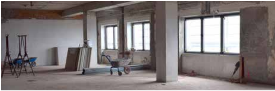
Die Fensterbänder sind eingebaut und der Rohbau ist somit fast fertig.
